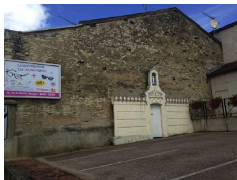
Brousseval - École des filles (ou plutôt ce qu'il en reste après qu'on l'ait mangée)
