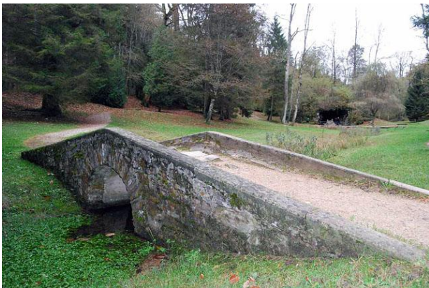
Premier pont sur la Seine
