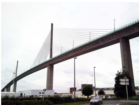
Le pont de Brotonne
