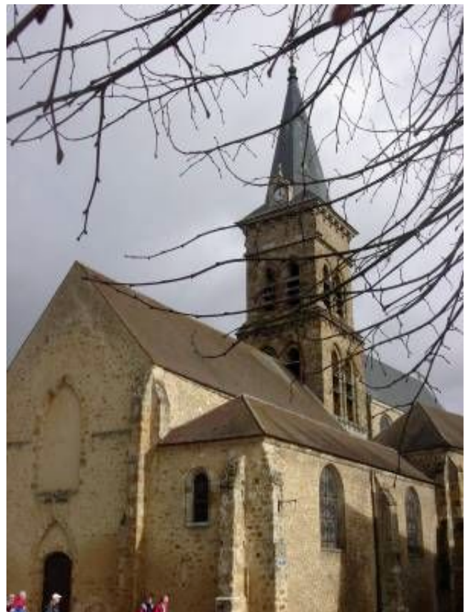
Église St Martin, construite en meulière dorée
