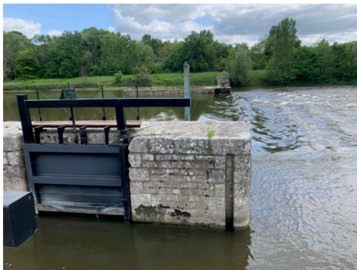
Barrage et écluse de Chisseaux
