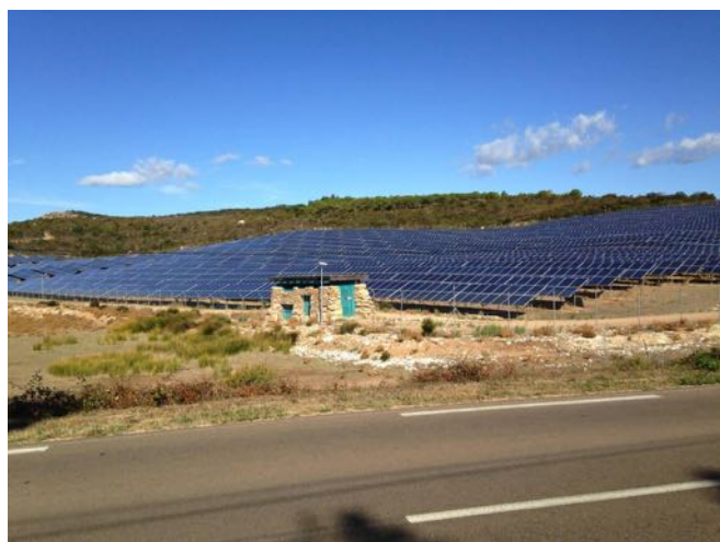
Champ de panneaux solaires
