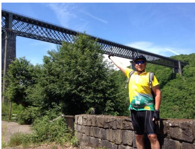
Viaduc des Fades
