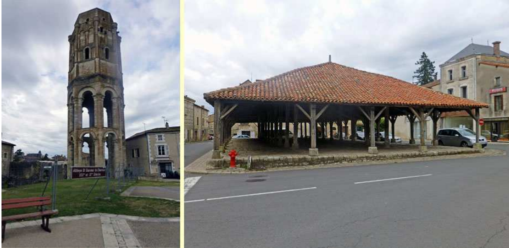
Clocher de l'ancienne abbaye de Charroux
